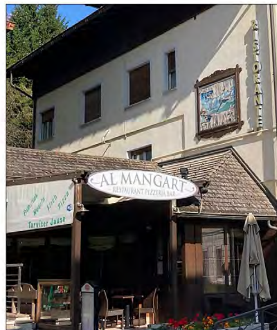
Abb. 2: Blick auf das ‚Al Mangart‘, Tarvisio (Ital.)
